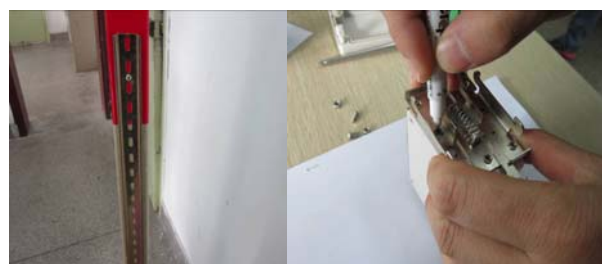
图 13 加装导轨 图 14 感应器固定卡座
